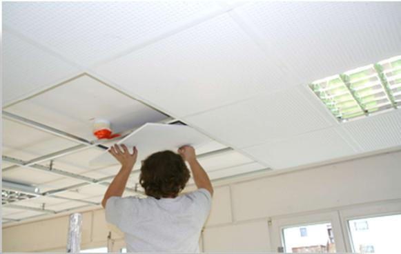
Ziel einer **Optimierung der Raumakustik** ist eine Verringerung der Nachhallzeit auf 0,4 Sekunden durch Minimierung schallharter Flächen. Dies wird beispielsweise durch den Einbau von Akustikdecken und das Anbringen schallschluckender Materialien an ausgewählten Wandflächen erreicht.
